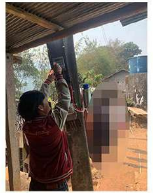
ซ่อมแซมไฟกิ่ง
